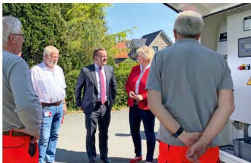
Die ehrenamtlichen Katastrophenschützer Jürgen Lösekann und Claus Meyer führten dem Ortsbeauftragten Diether Liedtke, dem Innenminister Boris Pistorius und der Landtagsabgeordneten Karin Logemann (von links) das Notstromaggregat NSA 60 kVA vor.
