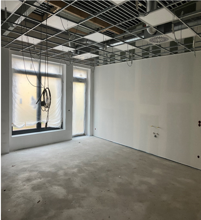
Hier entsteht ein Gruppenraum in unserer neuen Kita Märchenland.
