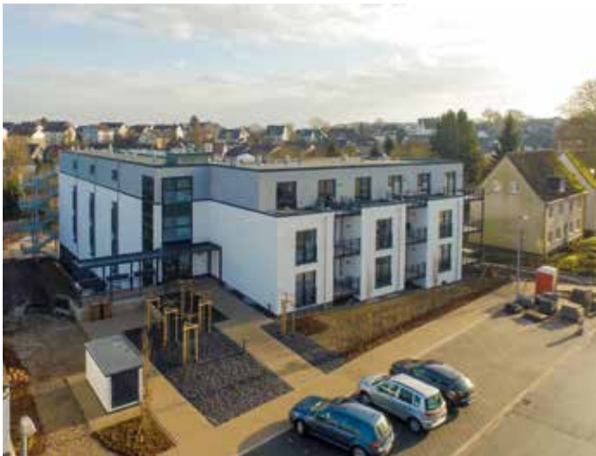
Seit Oktober bezugsfertig: die Seniorenwohnanlage in Breckerfeld.
