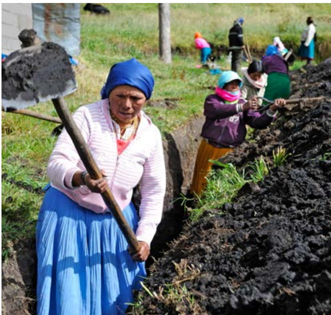
In traditioneller Gemeinschaftsarbeit – genannt „Minga“, werden die Rohre verlegt.
