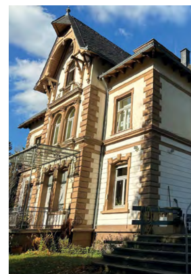
Das denkmalgeschützte Haus in Iserlohn bietet 12 Wohneinheiten und einen geschützten Raum für die Frauen.
