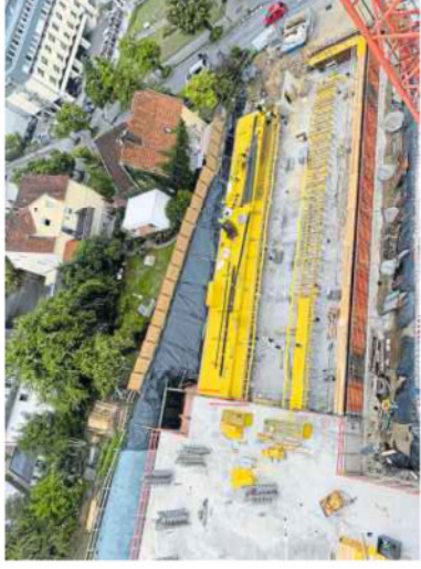
Der Blick aus der Kabine des Baukrans zeigt, was seit Baubeginn im April geschehen ist. Foto: Johanniter
