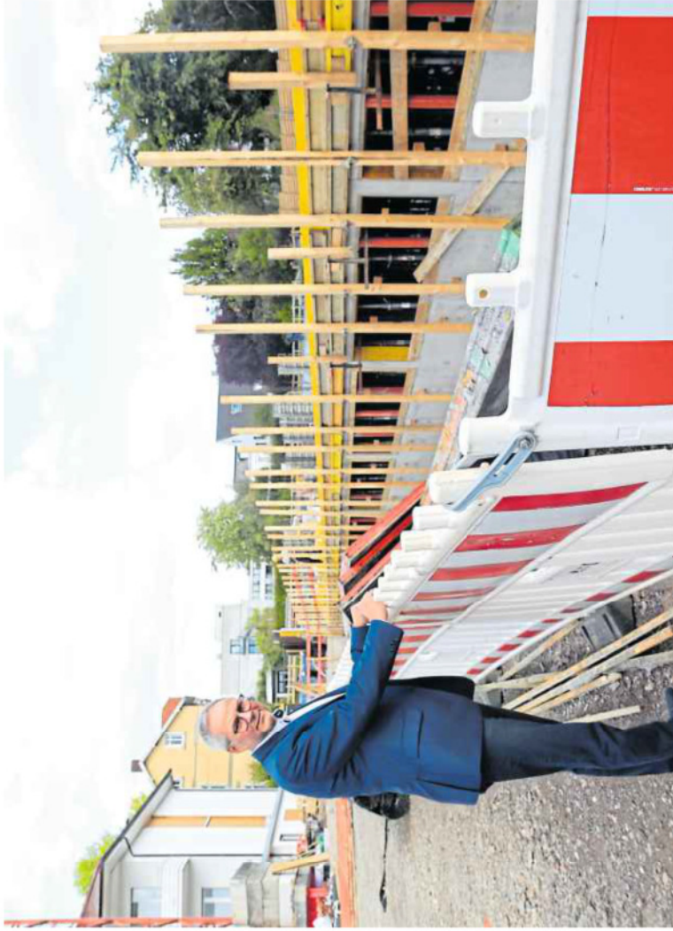
Michael Schelp freut sich, dass der Zeitplan derzeit eingehalten wird. Er hofft, dass das neue Klinikgebäude spätestens zum 1. Januar 2024 bezogen werden kann. Fotos: Heidi Froreich
