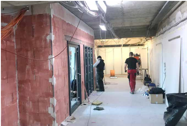
Die gesamte HNO Ambulanz in der 4. Etage wurde kernsaniert und mit modernster Technik ausgestattet
