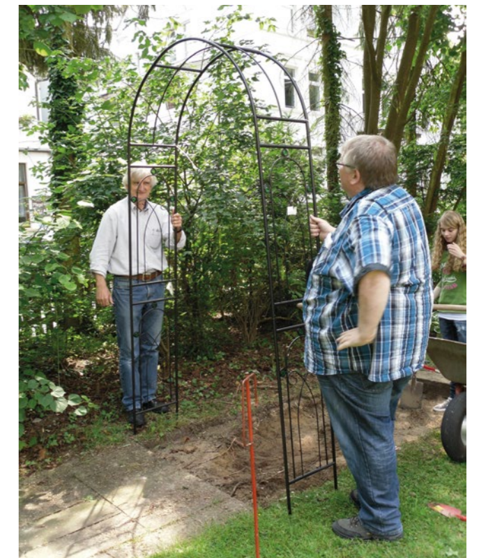
Der Rosenbogen wird installiert.
