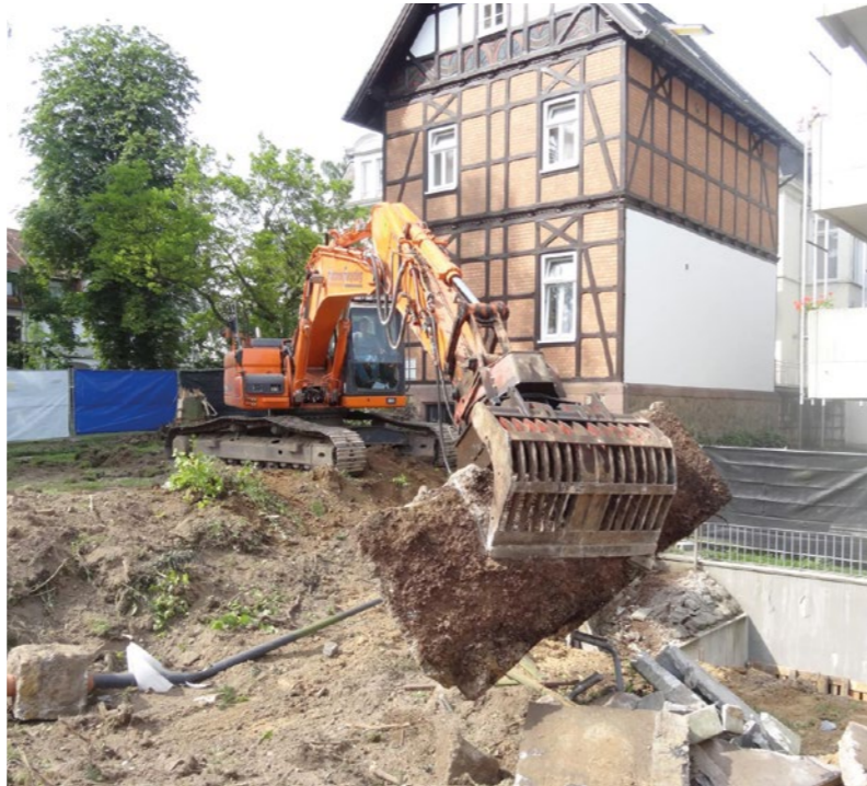
Die Bauarbeiten für den Erweiterungsbau der Klinik am Korso haben begonnen.
