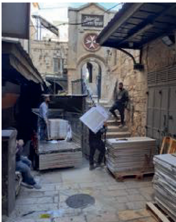
Eingang zum Johanniter Hospiz an der VIII. Station der Via Dolorosa. Dank der durch Corona bedingten Leere war die Belieferung der Baustelle (fast) problemlos.
