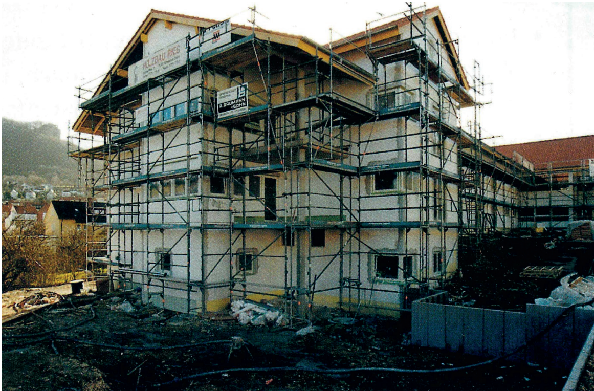
Der Rohbau steht - Aus dem Stadtarchiv
